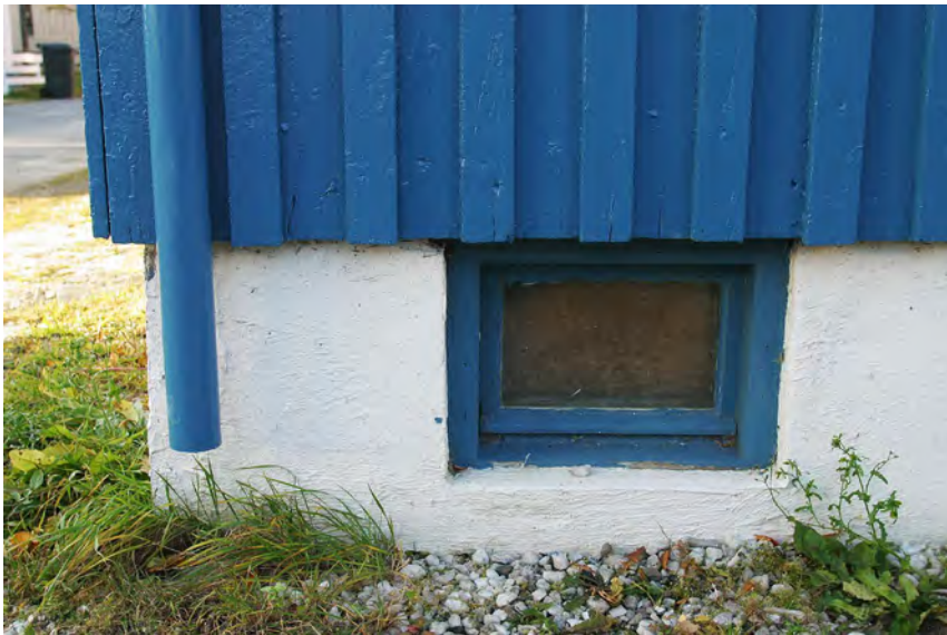
Nærbilde av kjellervind, viser hvordan avslutningen mot kjellermuren var og listverket rundt vinduet.
