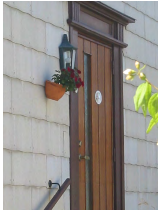
Fredenborgsveien, klassisk portal, ny dør
