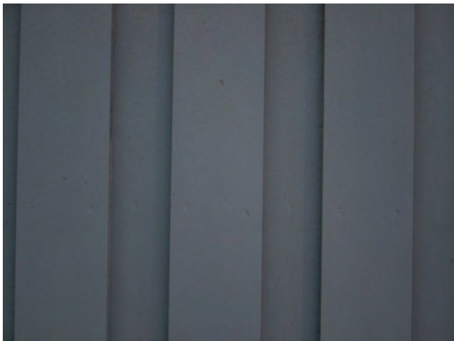
Eksempel på nytt panel, det er tydelig bredere enn det opprinnelige.
