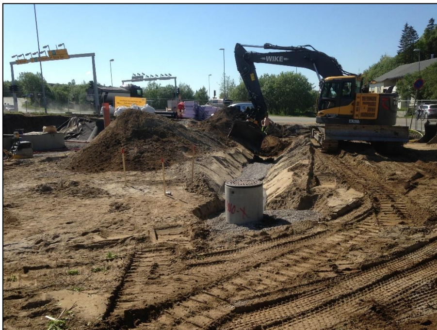
Bilde 3 – bilde av løsmasser fra etablering av bensinstasjon
