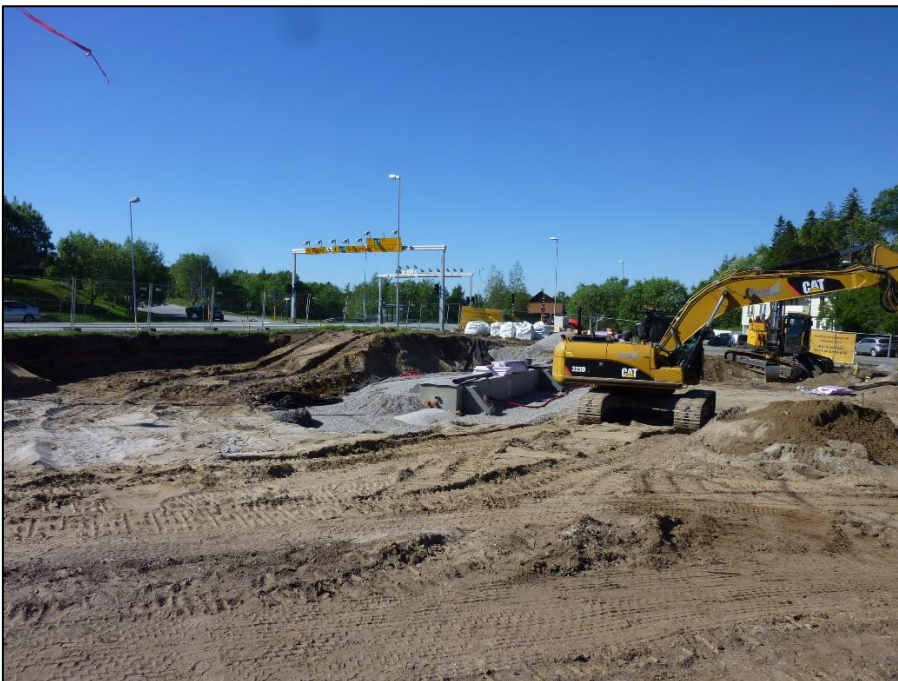
Bilde 2 – bilde av løsmasser fra etablering av bensinstasjon
