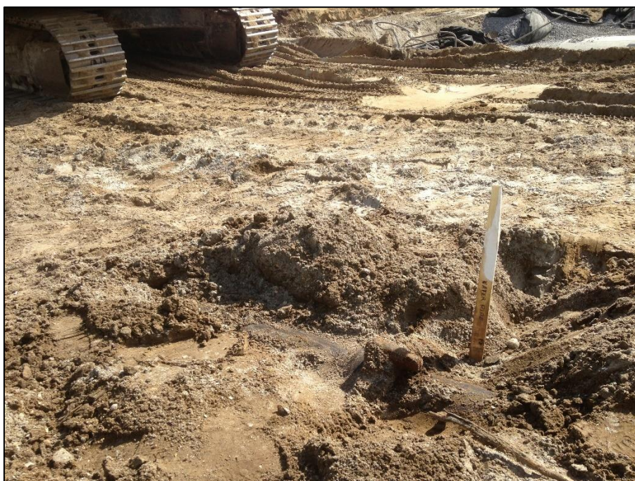
Bilde 4 – bilde av løsmasser fra etablering av bensinstasjon
