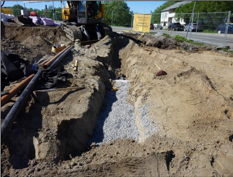
Bilde 1 – bilde av løsmasser fra etablering av bensinstasjon
