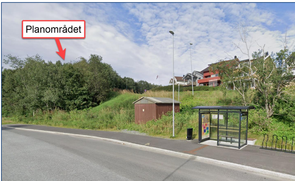
Figur 14 – Bussholdeplassen Lauvåsen, kilde: Google Street View 2022
