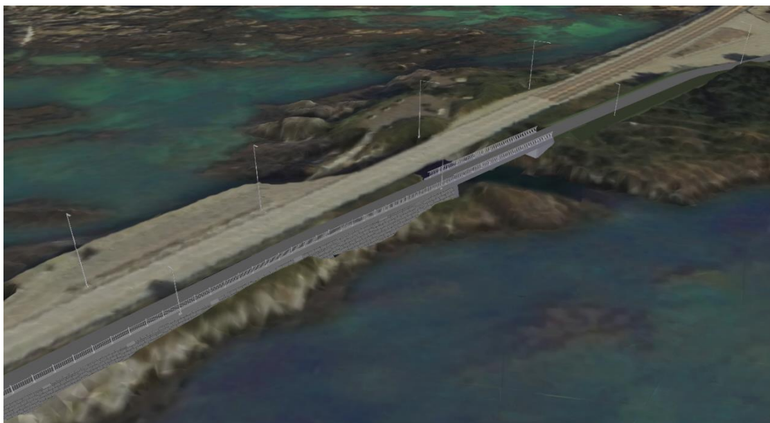
Figur 6.3: Illustrasjon av mulig løsning for ny bru og ny mur mellom gang- og sykkelveg og Godøystraumen.
