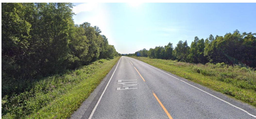
Figur 9.33: Starten på delstrekning 5 sett fra øst.
