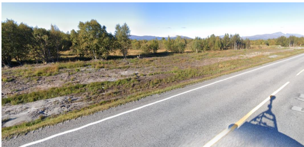
Figur 9.40: På nordsiden er vannledning gravd ned i kanten av vegen og myrområdet er fjernet.
