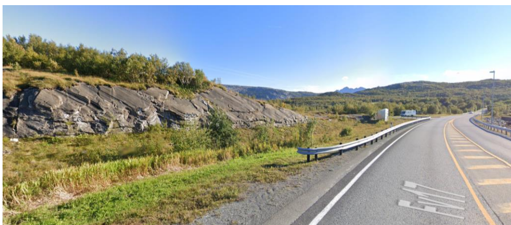
Figur 9.9: Den østre siden av vegen har en mer variert topografi, inneholder arealer der tidligere fv. 17 var plassert, sprengt fjell, rasteplass, tekniske installasjoner, berg og vegetasjon.
