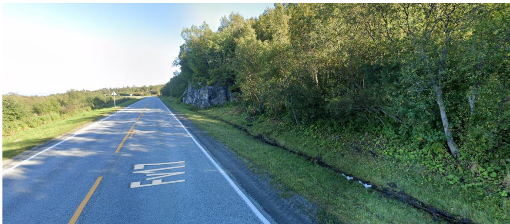
Figur 9.27: På slutten av Ytteråsen vises i dag en mindre bergskjæring som er nesten helt dekket med vegetasjon.
