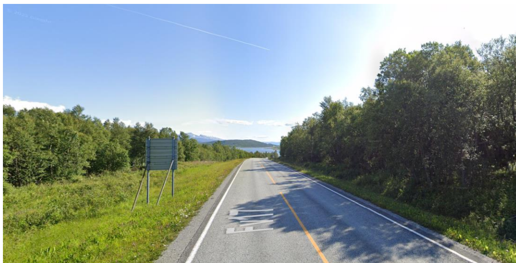
Figur 9.34: Overgang mellom delstrekning 4 og 5 mot øst.
