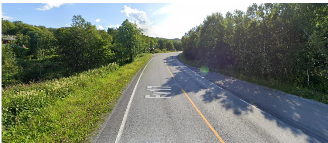
Figur 9.15: Fylkesvegen og ny gang- og sykkelveg passerer igjennom et område med tre- og buskvegetasjon Dette er en del av en sammenhengende grønnstruktur. På sørsiden må ny gang- og sykkelveg plasseres på fylling, men på nordsiden går den inn tungt i bortskjæring. Det nordlige alternativet gir større inngrep i terrenget og landskapet enn det søndre alternativet.
