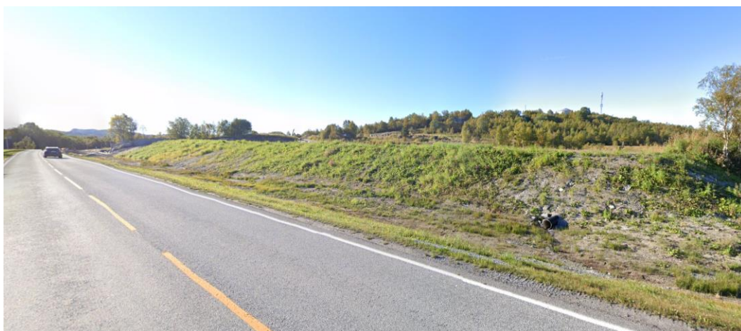
Figur 9.39: På nordsiden er det opprinnelige terrenget blitt endret på.
