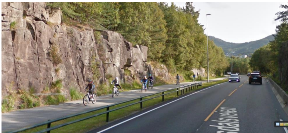
Figur 12.02: Eksempelbilde som viser smalere grøft ved bruk av rekkverk.
