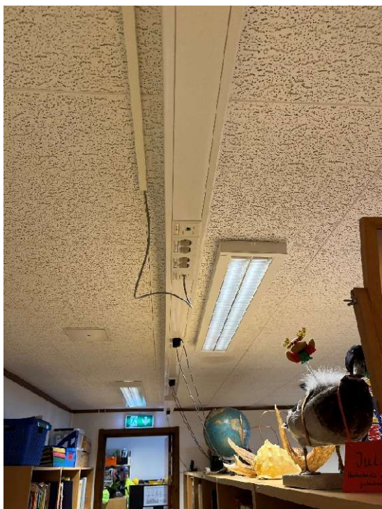
Eksempel på utvidelse/supplerende kursopplegg som er gjort. Metoden er fullgod og anvendes også ved nybygg.
