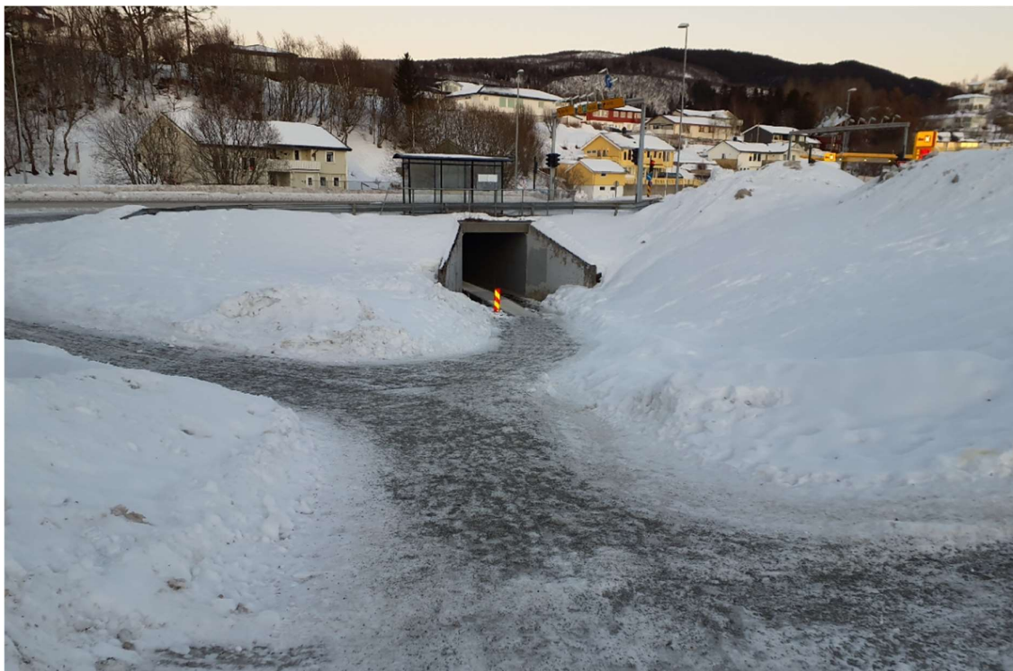
Bildet viser undergangen ved Fogdveien under RV80, sett fra sørsiden av riksveien.
