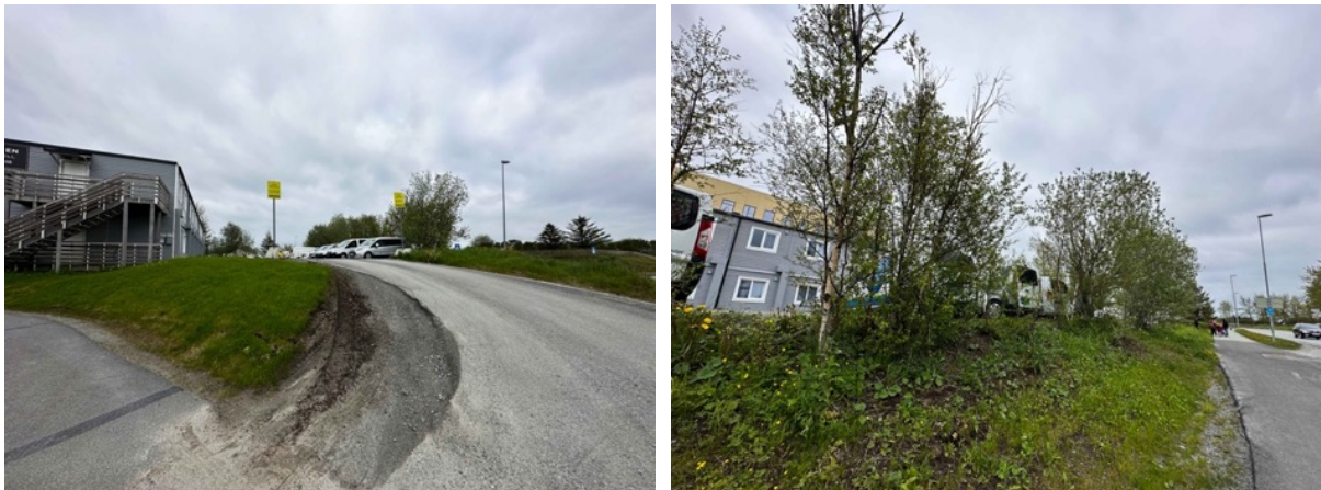
Figur 5.4.1 T.v. viser høydeforskjellen på tomte. Dette terrenget planlegges å tas ned til samme nivå som eksisterende kontorbygg. T.h. viser vegetasjonsbeltet imellom boligrigg og riksveien.
