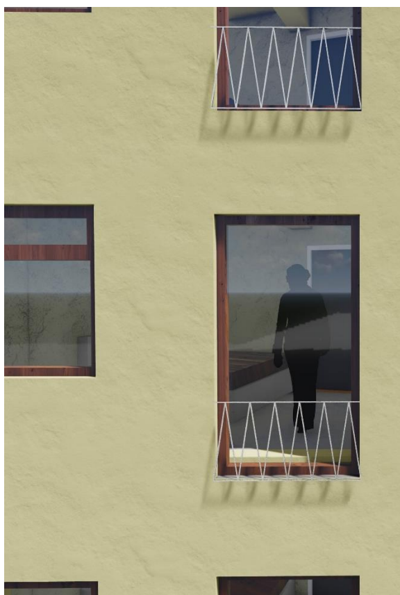
Figur 26. Vindu mot Sjøgata. Gitter foran vindu i samme stil som tidligere balkonger. Kilde: Norconsult AS
