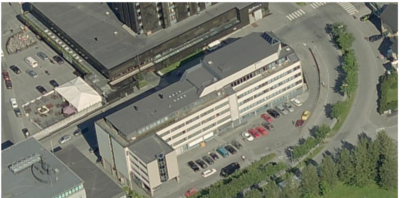
Figur 4: Figuren viser skråfoto av dagens bygningsmasse sett fra sør (gulesider)
