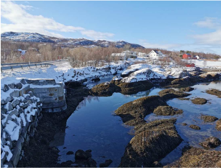
Figur 24 Godøystraumen vest har en sensitiv sammensetning med bergformasjoner i sjø og steinplastret skråninger og murer. Bygging av en GS-veg her vil forringe store deler av området.
