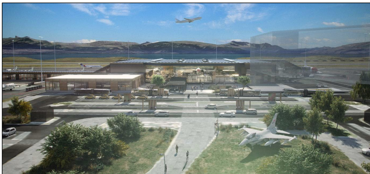
Figur 31: Bygningsmasse med forplass – sett fra nord
