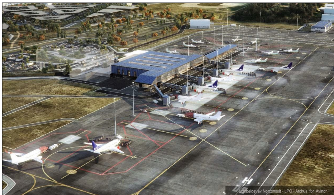
Figur 27: Terminalen sett fra syd øst, med taket dekket av solceller og glassfasader mot syd
