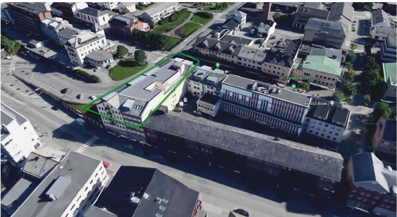
Figur 2 – Bygningsmassen i Storgata 19 som inngår i planarbeidet (innenfor grønn avgrensingslinje). Kilde: Google Earth.
