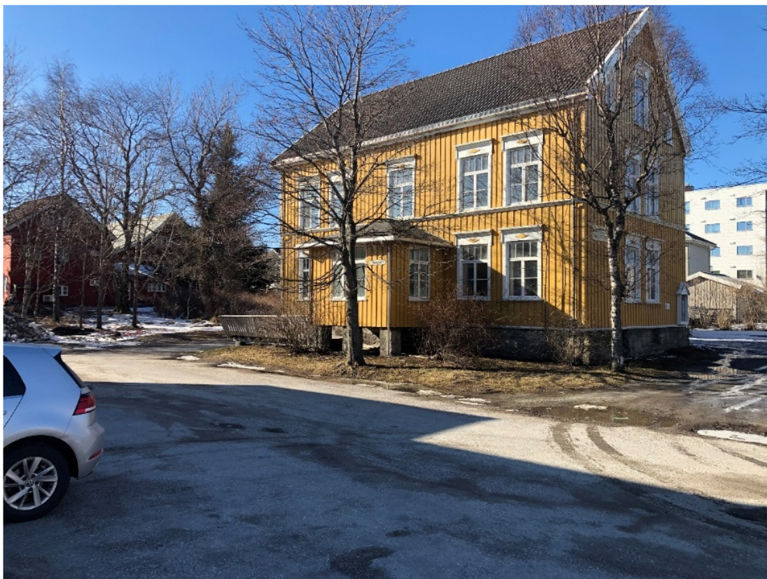
Figur 4. Buggegården sett fra sydøst, fra innkjørselen til tannklinikken. Foto Gisle Jakhelln april 2022.
