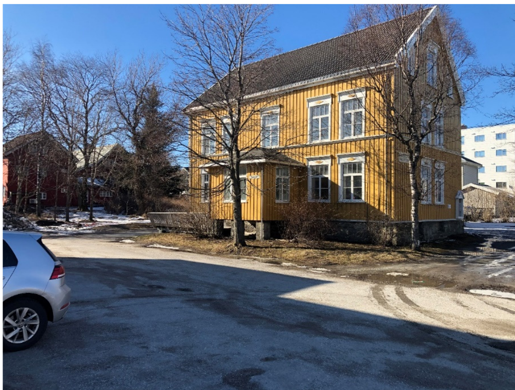
Figur 1. Buggegården sett fra sydøst, fra innkjørselen til tannklinikken. Foto Gisle Jakhelln april 2022.
