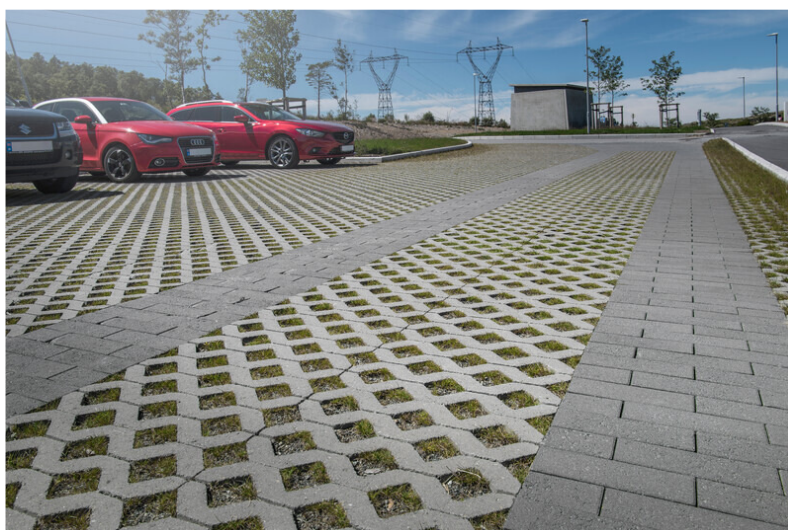
Figur 7. Eksempel på permeable dekker. Gressarmeringsstein Multiblokk DSC1964.
