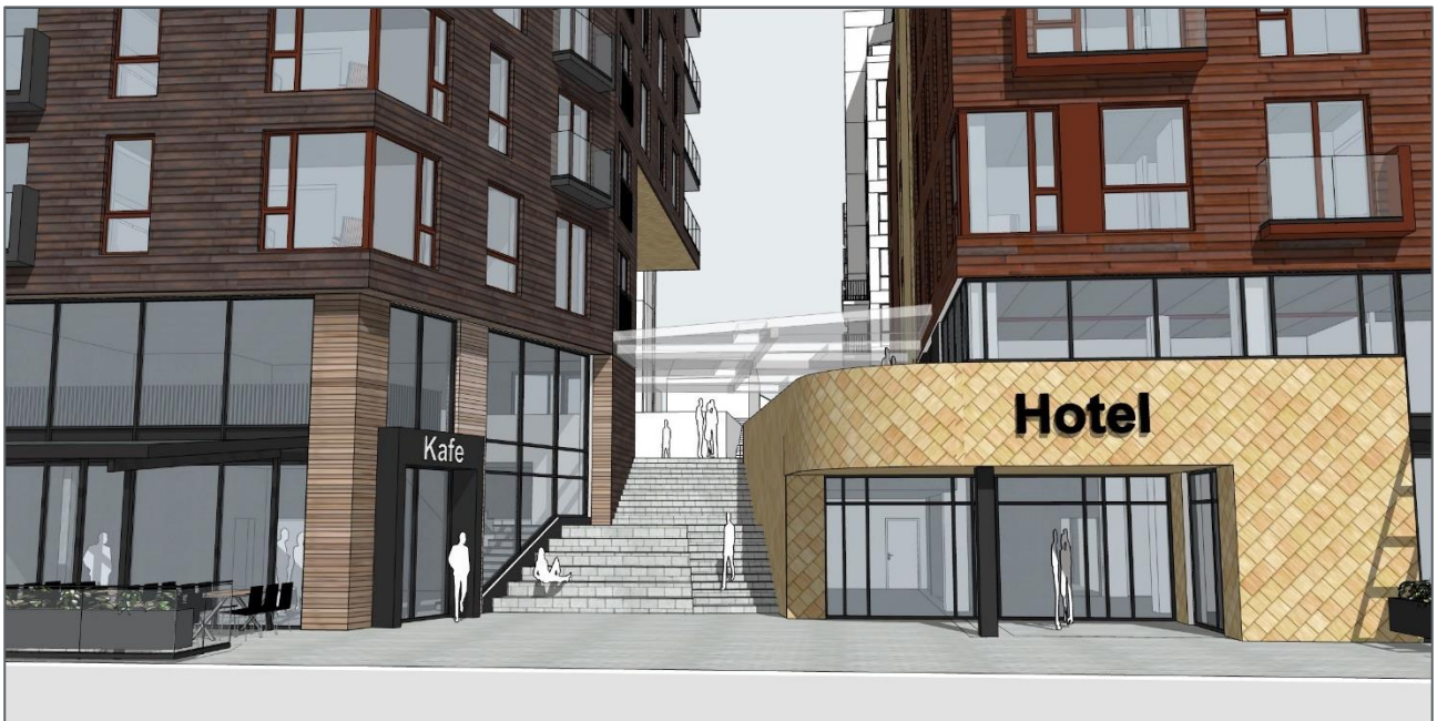
Figur 30. Passasjen mellom bygningsvolumene sett fra Moloveien mot Konrad Klausens vei. Kilde, Norconsult AS
