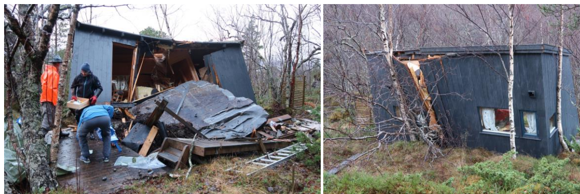
Bilde 1(til venstre): Hytta etter steinspranget sett mot nord, bilde 2 (til høyre) hytta sett mot sør
