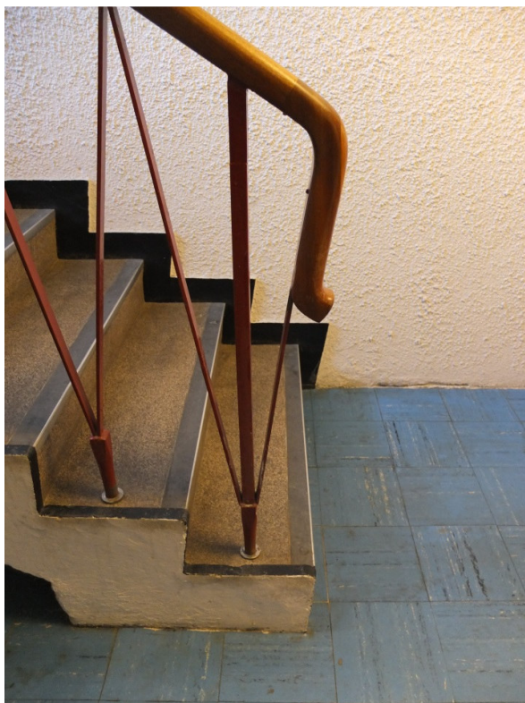
Figur 37 Bitrapp med opprinnelig rekkverk. Nyere belegg i trappen, opprinnelig belegg på gulv. Kjeller og 3. etg. østfløy. Foto 2017. Se også fig. 47 og 48.
