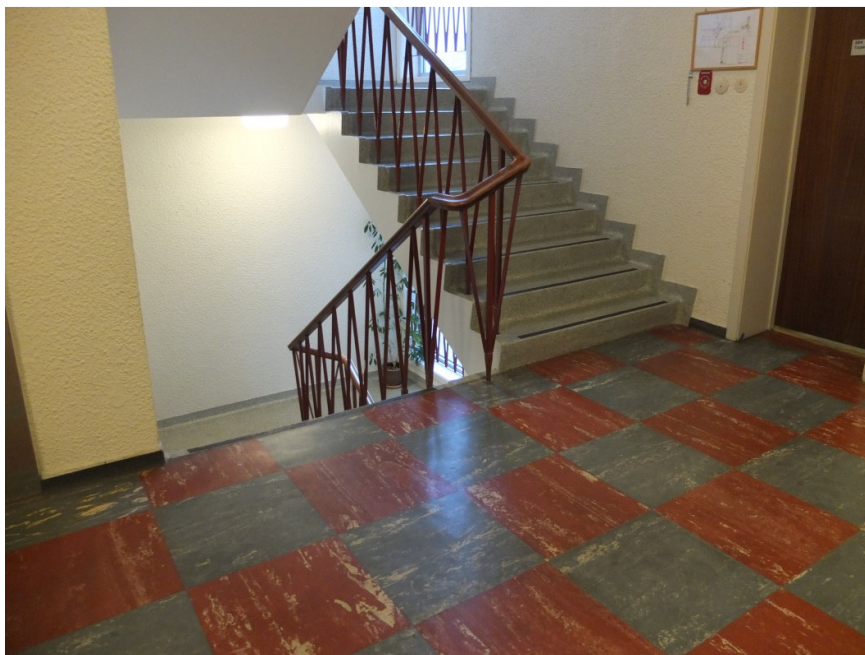
Figur 36. Gulvbelegg gummi fliser i hovedtrapp, opprinnelig type. Foto 2017
