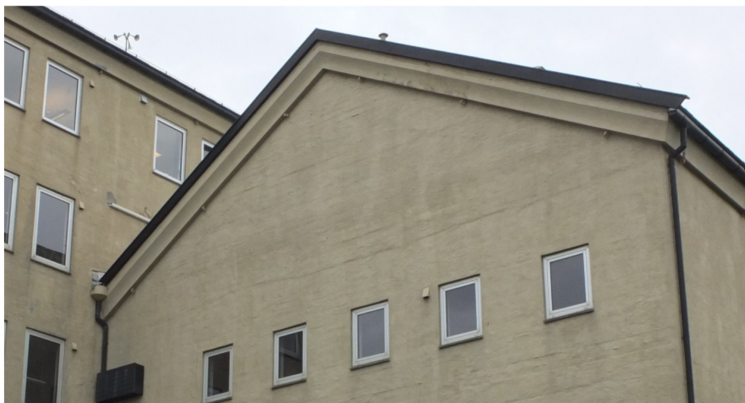
Figur 28 Knapp detaljering ved gavl og gesims. Vestfløyens nordvegg. Foto 2017.
