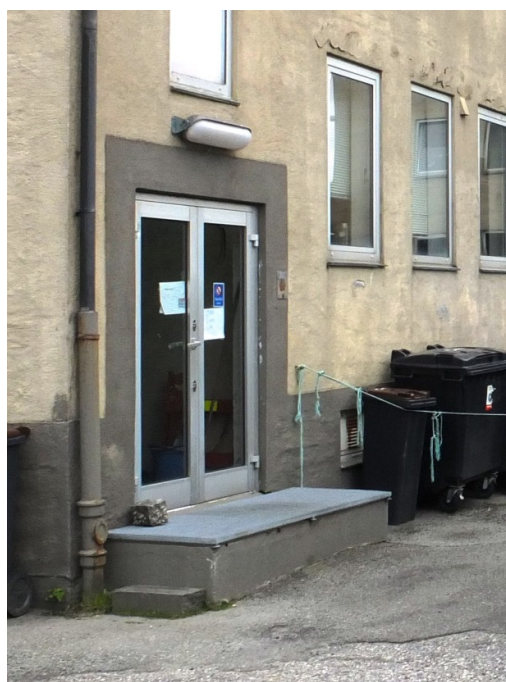
Figur 30 Markering rundt ytterdør i nordveggen østfasade. Dør i aluminium. Foto 2017
