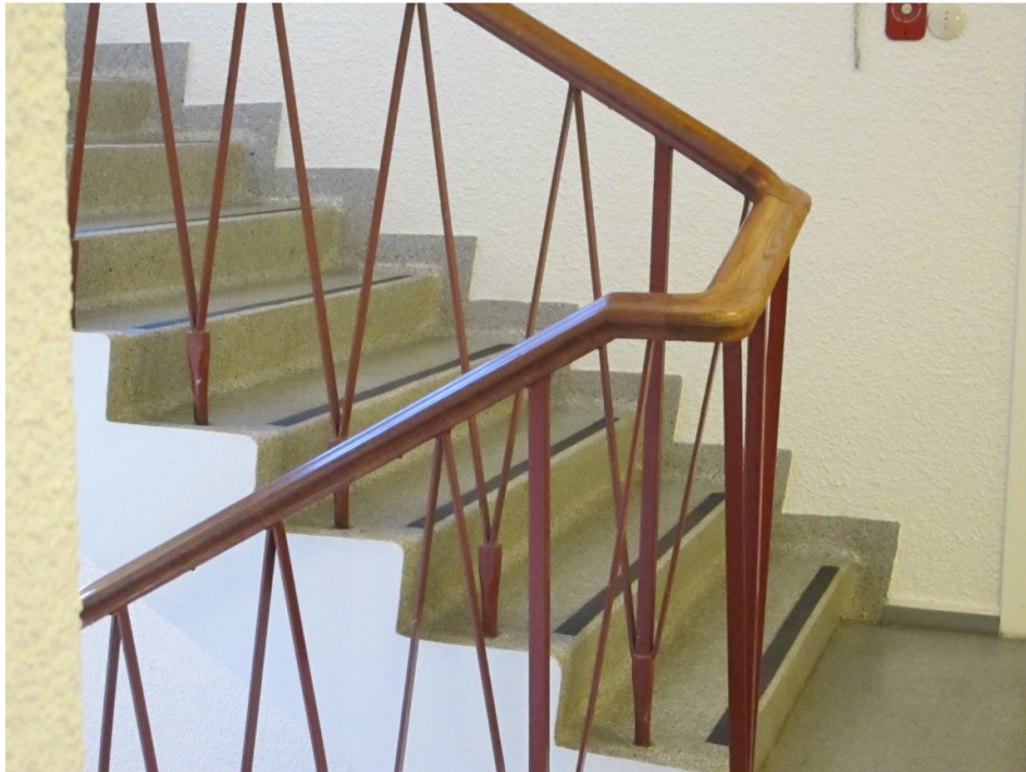
Figur 47. Hovedtrappens rekkverk. Foto Bjørg Heggstad Jakhelln 2017
