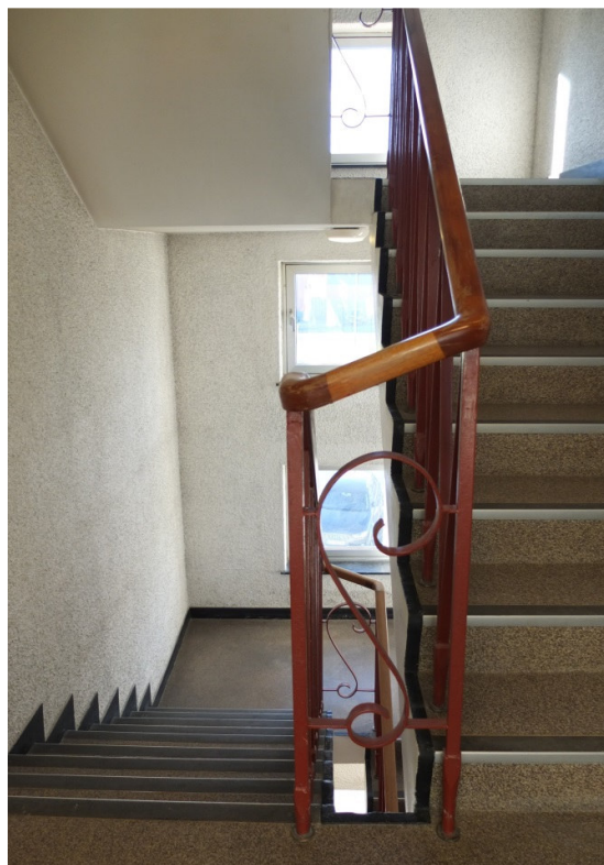
Figur 37 Bitrapp med opprinnelig rekkverk. Nyere belegg i trappen, opprinnelig belegg på gulv. Kjeller og 3. etg. østfløy. Foto 2017. Se også fig. 47 og 48.
