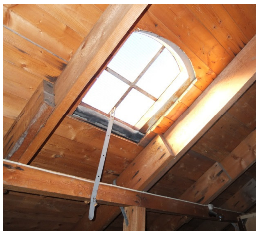
Figur 31 Takvindu mot nord i vestfløyen. Foto 2017
