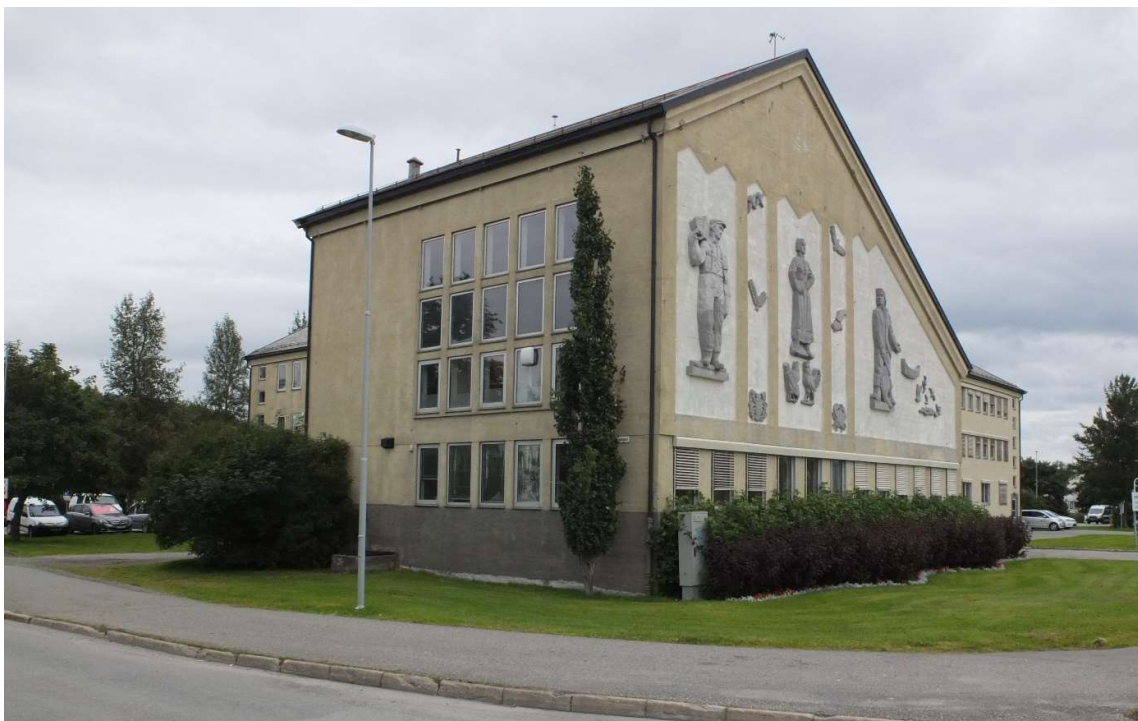
Figur 12. Herredshuset sett fra vest, fra krysset Gjerdåsveien/Rv 80. Foto Gisle Jakhelln august 2017.
