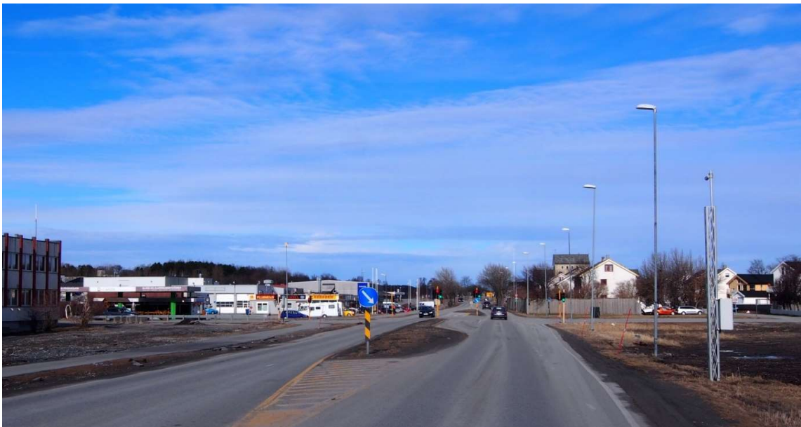
Figur 8. Herredshuset sett fra øst 2010, fra Rv 80 mot Thalleveien, med 2-etasjes bebyggelse rundt. Firkanten til venstre. Sammenlign med foto nedenfor fra 2020. Foto BOARCH 2010.
