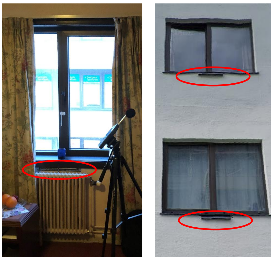
Figur 6 Eksisterende spalteventiler under vinduer markert med rød farge.
