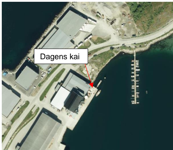
Figur 1: Flyfoto over eksisterende kai
