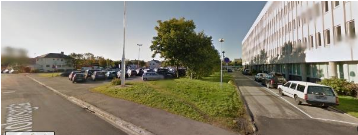
Figur 28: Dagens areal med plen og trær mellom parkeringsplass og eksisterende Fylkeshus.
