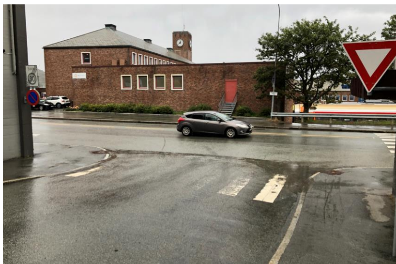
Figur 3: Manglende merking av vikelinje asfalten ved utkjøring fra Biskop Kroghs gate til Sjøgata
