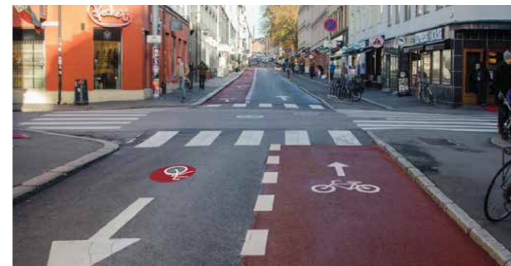
Figur 9: Figuren viser sykkelfelt i enveiskjørt gate. Sykkelfeltet er markert med rød asfalt. Symbolet i kjørebanelen er et eksempel på alternativ til sharrows. Kilde: Oslo kommune, Bymiljøetaten (Oslostandarden for sykkeltilrettelegging).
