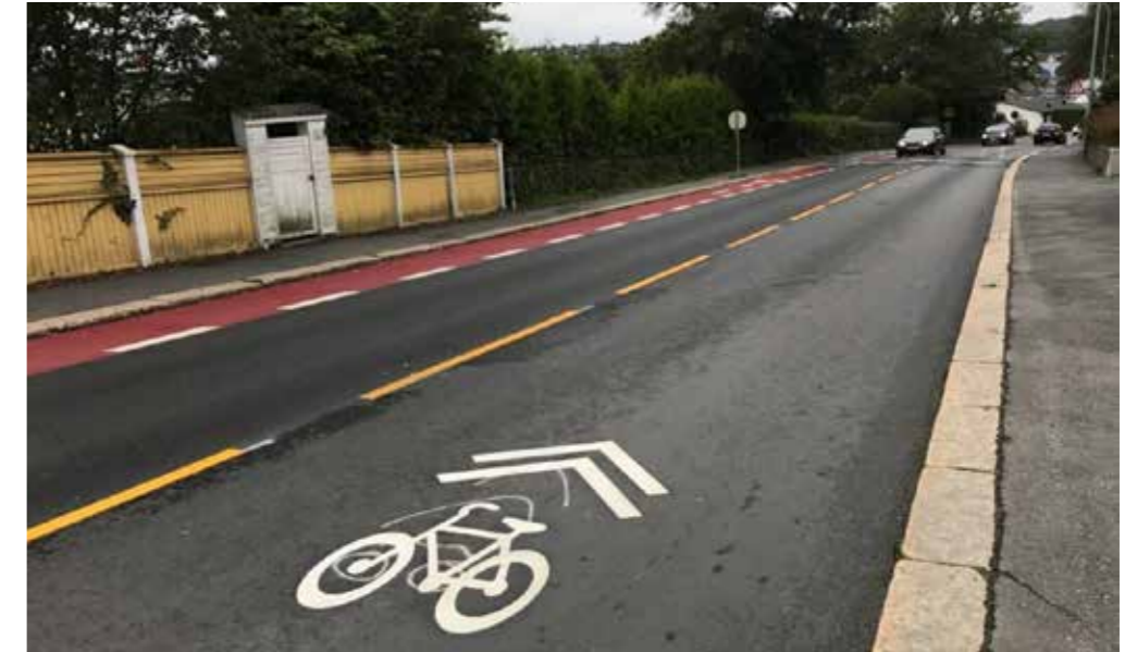
Figur 12: Eksempel på bruk av sharrows i en retning og dedikert sykkelfelt motsatt retning. Dette kan være en god løsning dersom det ikke er plass til sykkelfelt i begge retninger.
