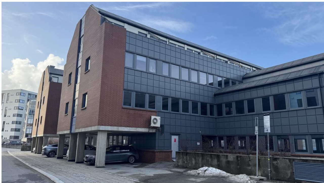
Figur 37. Bilde som viser dagens parkeringssituasjon i Konrad Klausens vei ved Moloveien 10. Foto, Ayla Kristensen, Norconsult Norge AS.
