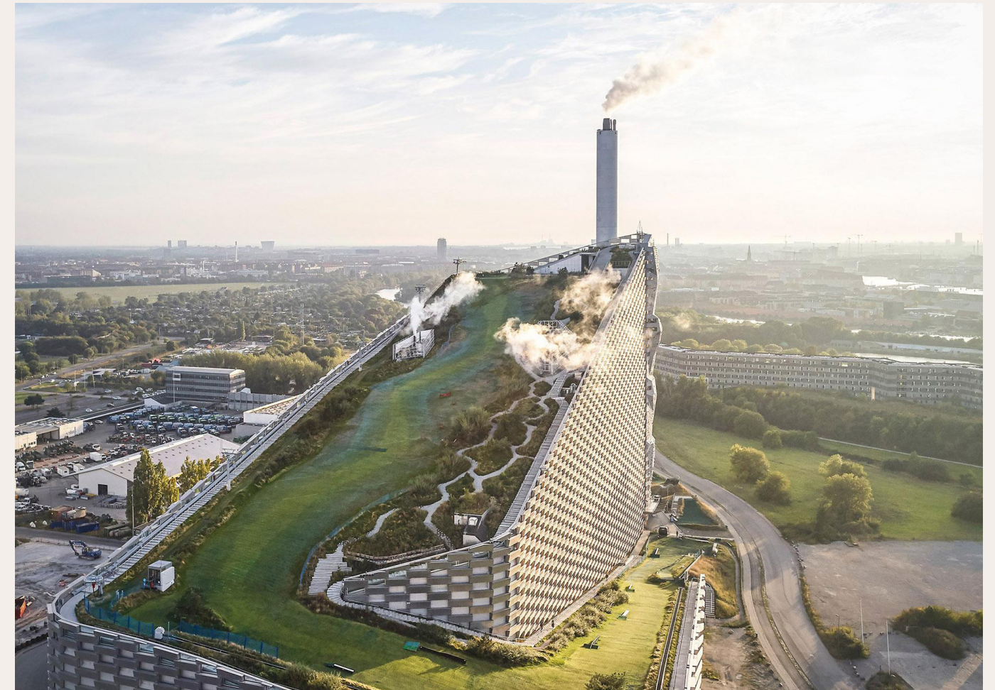
Amager Bakke, København: Et avfallsenergianlegg med skibakke, tursti, klatrevegg, skitleining og after-ski bar
