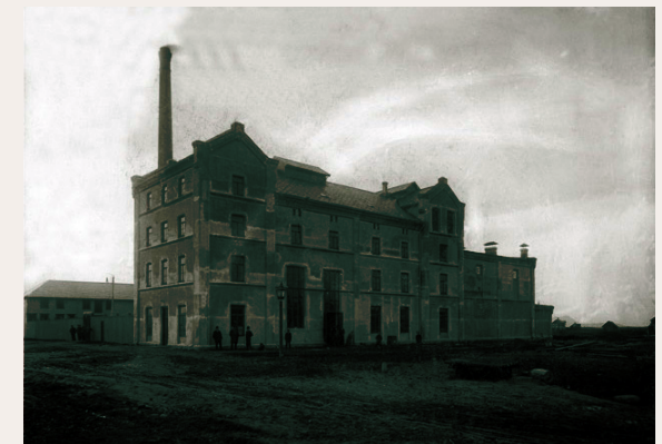
Nordlandsbryggeriet oppført i 1897
