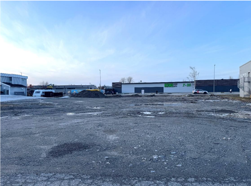
Figur 5 - Eiendommen til Norfloor eiendom AS sett fra sør.
