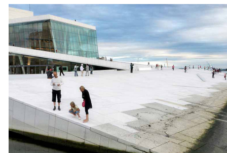
SKRÅNENDE møte med vannet, Operaen i Oslo.
