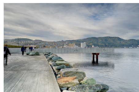
UTSIKTSPLATTFORM svever utover kanten, Brattørkaia i Trondheim.
