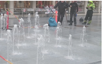
Lekeplass opparbeides og vannfontener etableres i bygulvet
