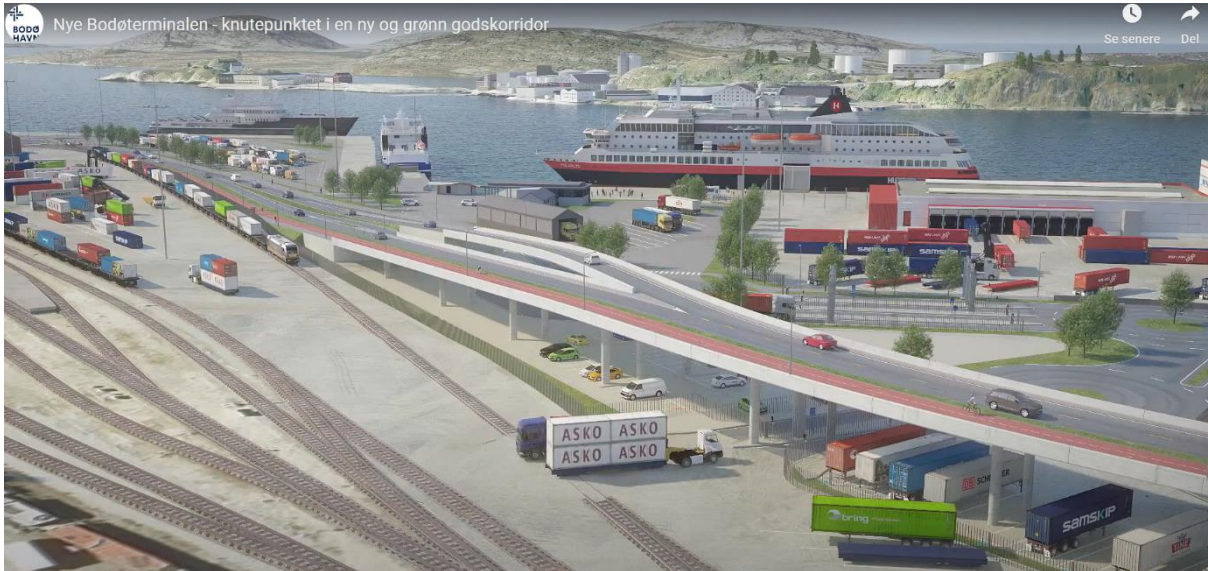
Figur 6. Ny bru i Jernbaneveien. Gods fraktes sømløst mellom bane og havn med terminalutstyr under ny bru.
