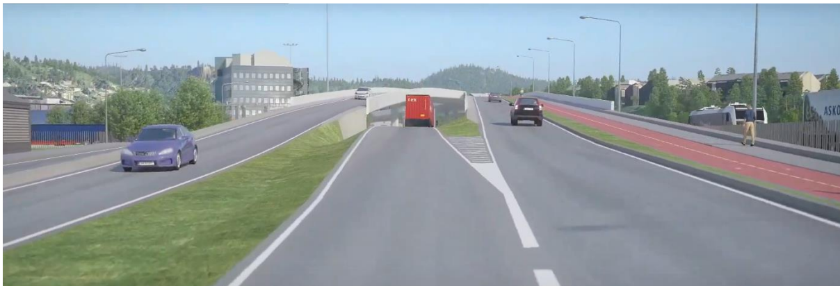
Figur 7. Ny planskilt hovedadkomst til terminalområdene på sørsiden av ny bru i Jernbaneveien.
