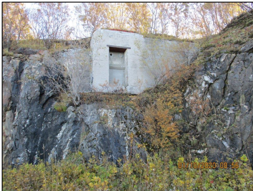
Figur 21 Bunker med igjen støpt inngangsparti, reg.nr. 11. Foto H.P. Lyngsnes.
