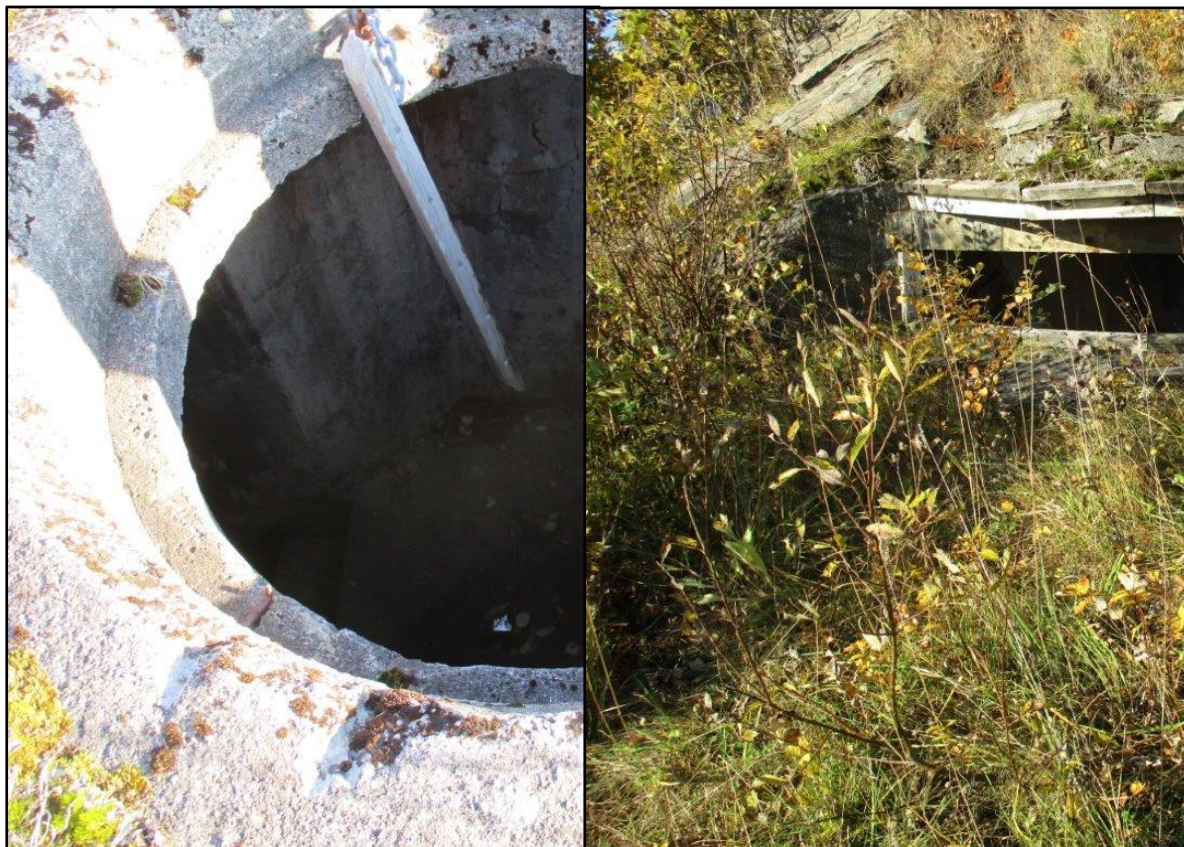
Figur 26 En bunker og MG Ringstand, reg.nr 22.. Foto H.P. Lyngsnes.
