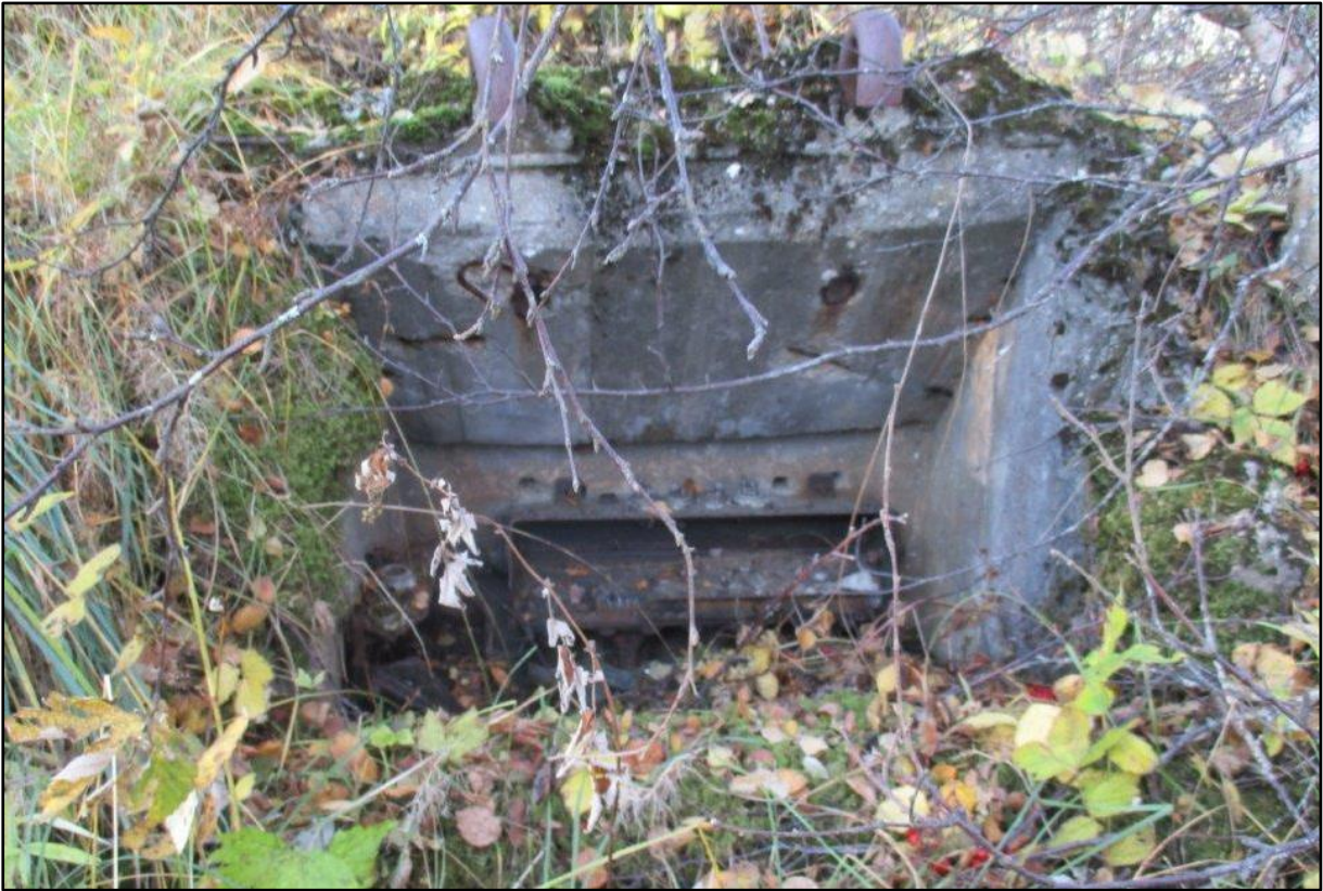
Figur 40 Rester etter et koblingspunkt for militært samband. Foto H.P.Lyngsnes..
