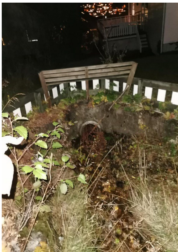
Figur 13: Bekkelukkinger ovenfor Geitskaret, i Skivika. Det ble rapportert om mye løv og kvist i ristene, samt tendens for tilgroing. Foto: Bodin Videregående skole
