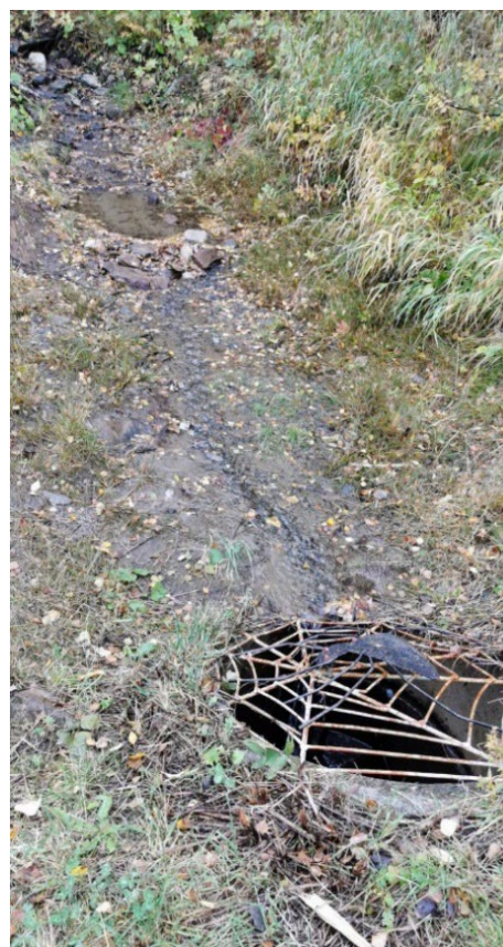
Figur 13: Bekkelukkinger ovenfor Geitskaret, i Skivika. Det ble rapportert om mye løv og kvist i ristene, samt tendens for tilgroing. Foto: Bodin Videregående skole
